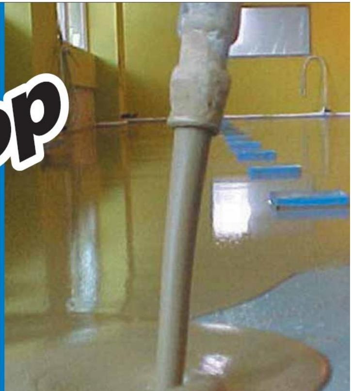
**Быстросхватывающийся самовыравнивающийся состав на основе специальных гидравлических вяжущих для производства износостойких полов толщиной от 5 до 40 мм.**
